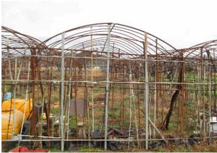
写真1 老朽化した連棟ハウス
