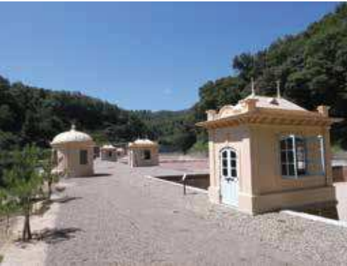
<国重要文化財> 旧美歎水源地水道施設
