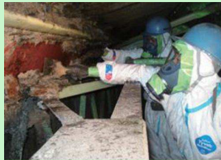
吹付け石綿の除去作業の様子
