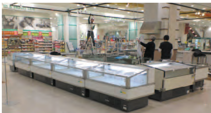
現場施工風景
