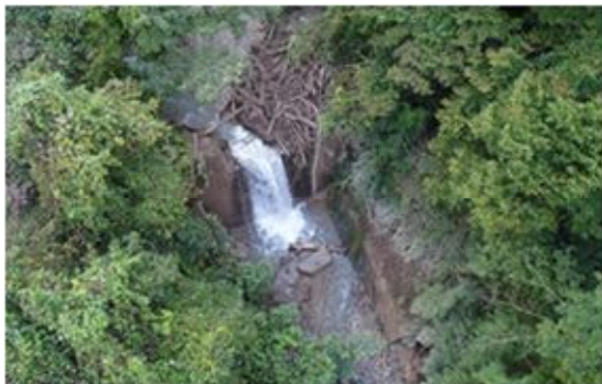
【流木捕捉状況 (H29 鳥取市河原町北村)】
