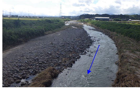
<河道掘削：洗川（琴浦町丸尾）>
