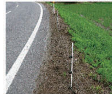
道路際に設置された危険な電気柵
