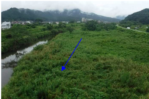
< 樹木伐採: 河内川 (鳥取市鹿野町鹿野) >
