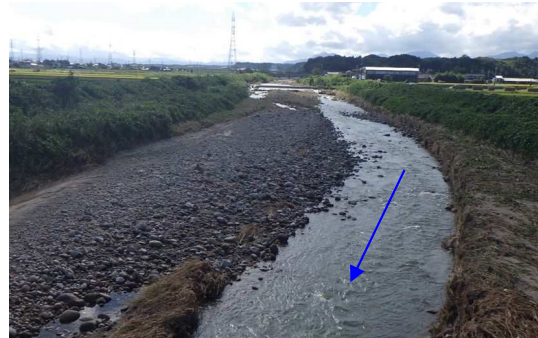
< 河道掘削: 洗川 (琴浦町丸尾) >
