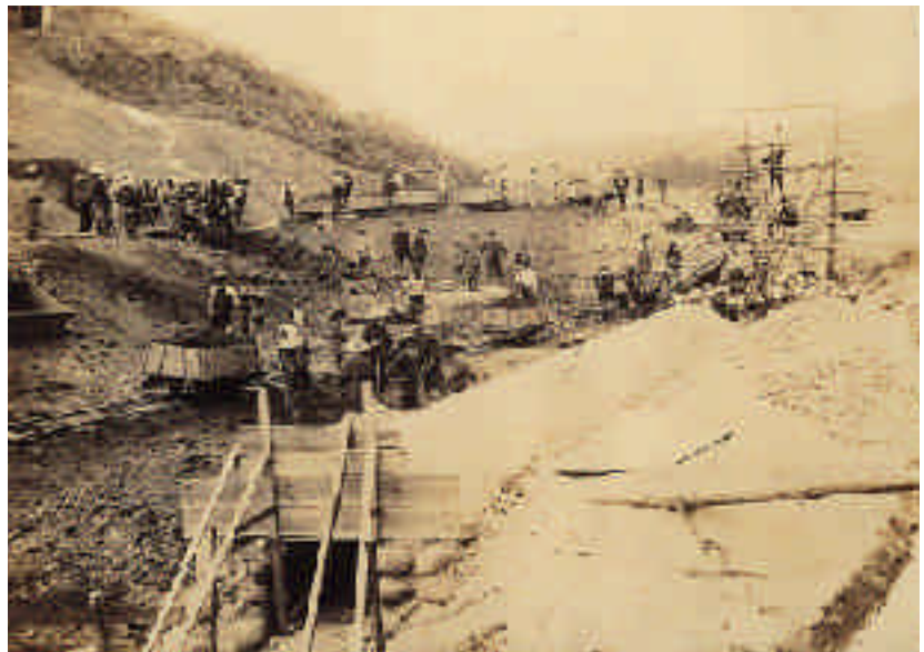
↑ため池工事の写真（1922（大正11）年頃）
