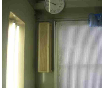
▲エアコン設置
