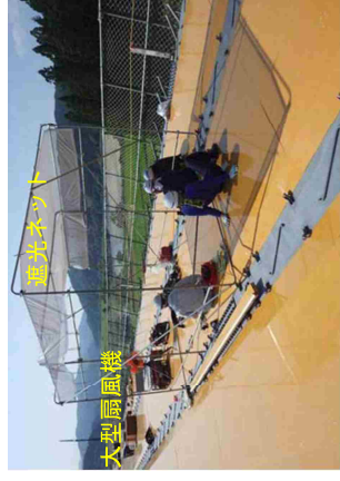
▲遮光材入りのメッシュシートによる日除け設備と大型扇風機の設置
