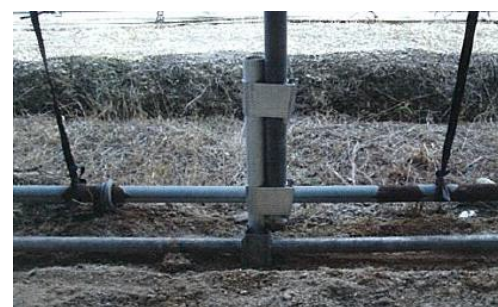
写真5 パイプ地際の腐食部分の補強
