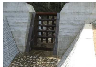
透過型砂防堰堤の新設
