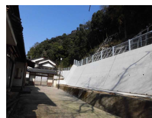
擁壁工の整備
