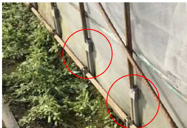
写真 パイプハウスの地際部補強(○枠)の例
