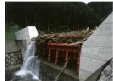
【流木捕捉状況】
