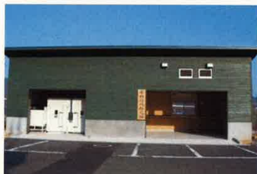
完成した「木材環境研究棟」 (乾燥や寸法変化、断熱性などの試験を行います)
