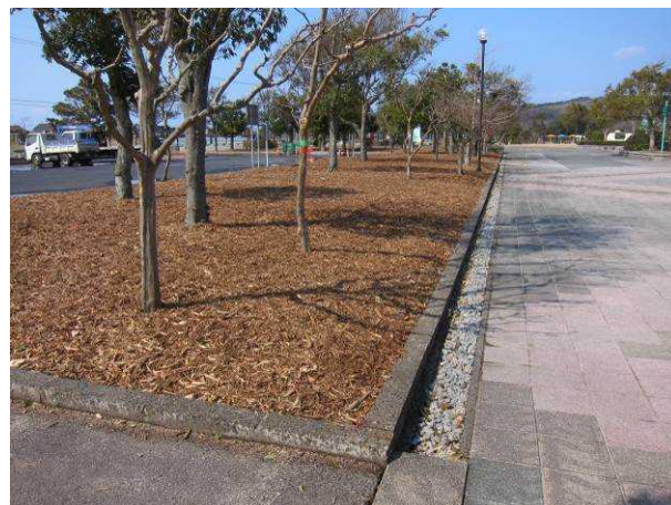
施工後(隣接駐車場ゾーン)
