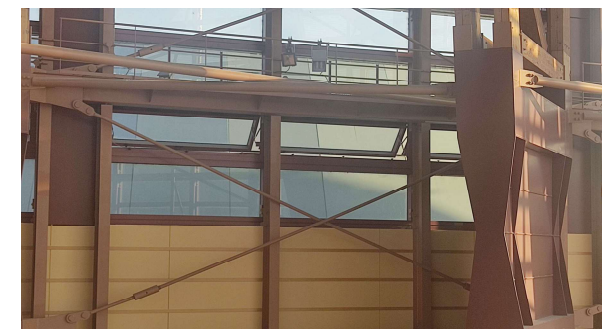
▲正常時はこの写真のとおり、排煙窓が開放する。
