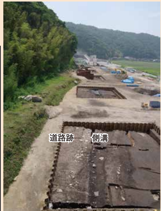
青谷横木遺跡の道路跡 (北西から撮影)
