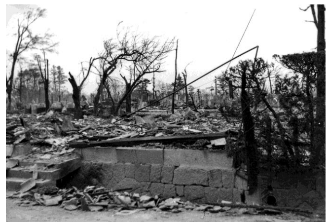
焼失した建物（昭和27年4月19日撮影）
