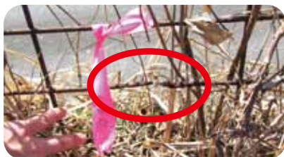
腐食して切れている
