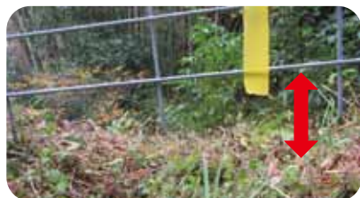
地面から浮いている
