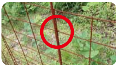
結束が1ヶ所しか残っていない
