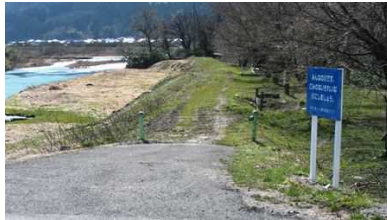
八東川堤防(2カ所)に設置
