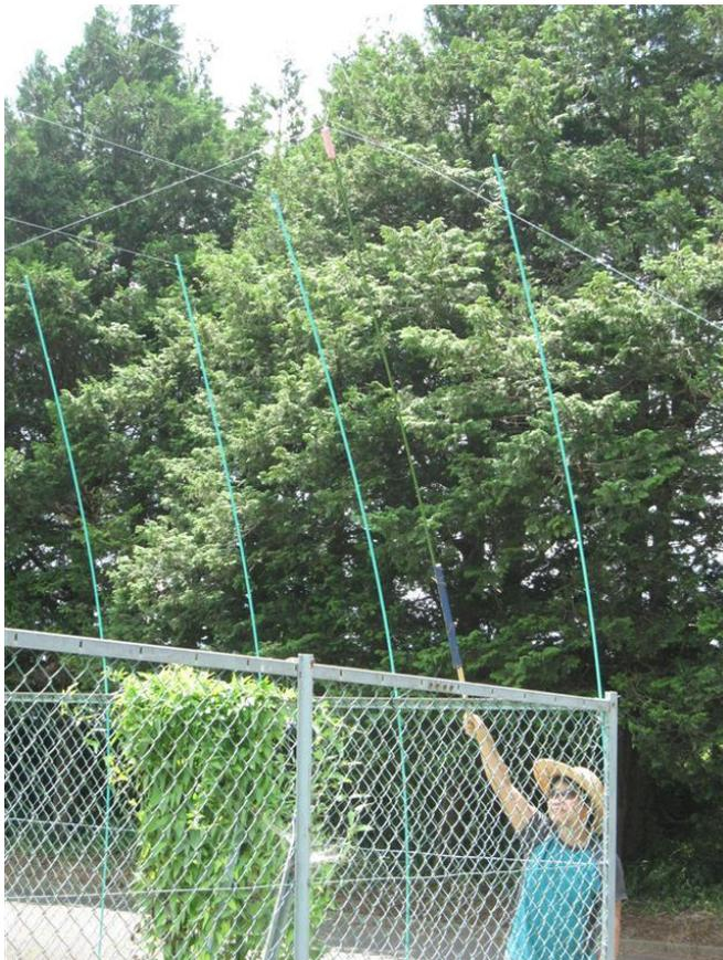
写真7 手製のY字竿を使い、新しいテグスを既に張ったテグスの上に載せる
