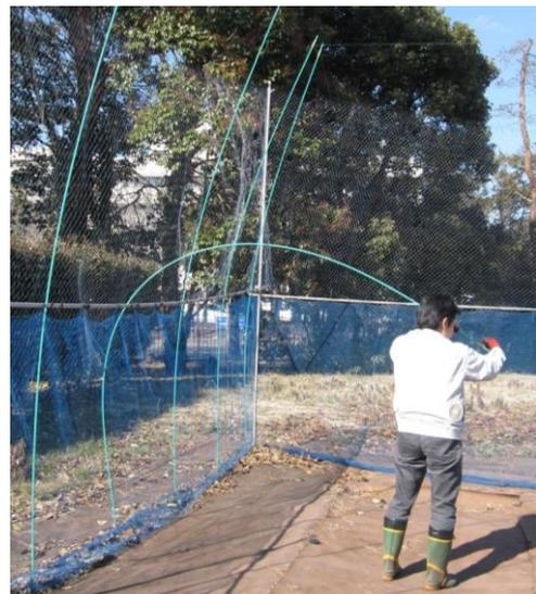
写真5 脚立を使わずに弾性ポールを曲げてテグスが張れる
