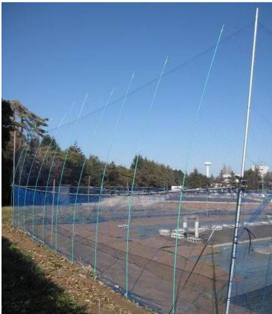
写真4 弾性ポールの先端近くにテグスを結んで、弾性ポールが軽くしなる程度に張る
