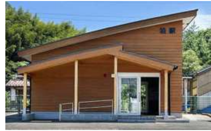
改修後のJR泊駅外観
