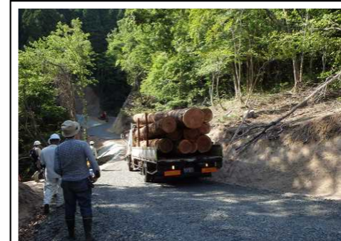
【林業専用道の整備】 林道までの木材運搬は林内作業車や2トン程度のトラックで行われていましたが、大型トラックが通行できる林業専用道を整備することで大幅な時間短縮とコストの削減に繋がっています。(日南町上萩山)
