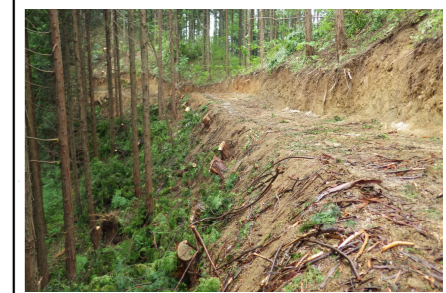
【鳥取式作業道の推進】 災害に強く、長期間の使用に耐えるように、転圧等丁寧な施工と、早期緑化を行うための表土ブロックを施工する作業道の作設を推進している。
