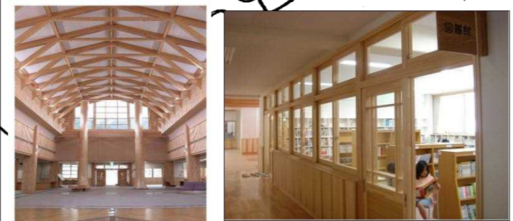
【日南町庁舎・日南小学校】 地域で生産・加工された木材を使用した木造公共施設。地域材利用のシンボル。 日南小学校には(株)オロチのLVL使用。 (日南町霞)
