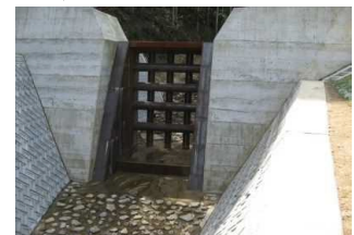
透過型砂防堰堤の新設
