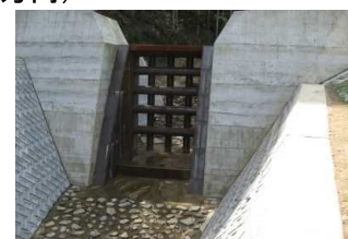
透過型砂防堰堤の新設
