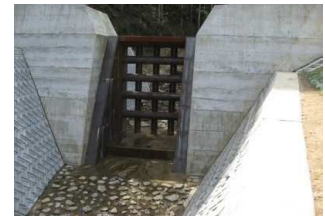
透過型砂防堰堤の新設
