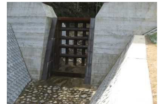
透過型砂防堰堤の新設
