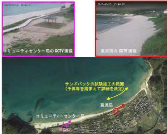
図 5-3 CCTV の撮影地点・撮影画像 (アングルの変更、拡大・縮小は可能)
