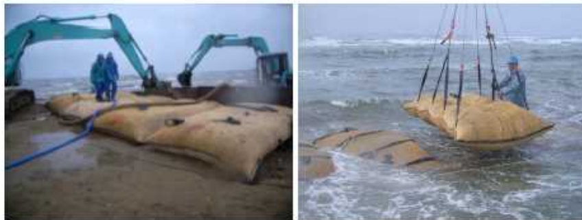
図 5-6 ミニサンドバックの設置・施工状況の例
