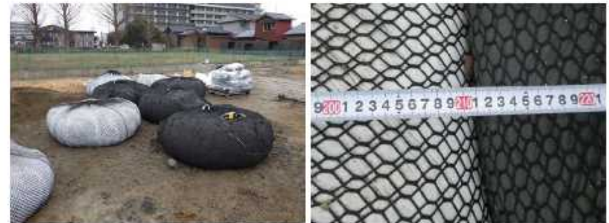
図 5-8 袋詰砂工の設置・施工状況の例
