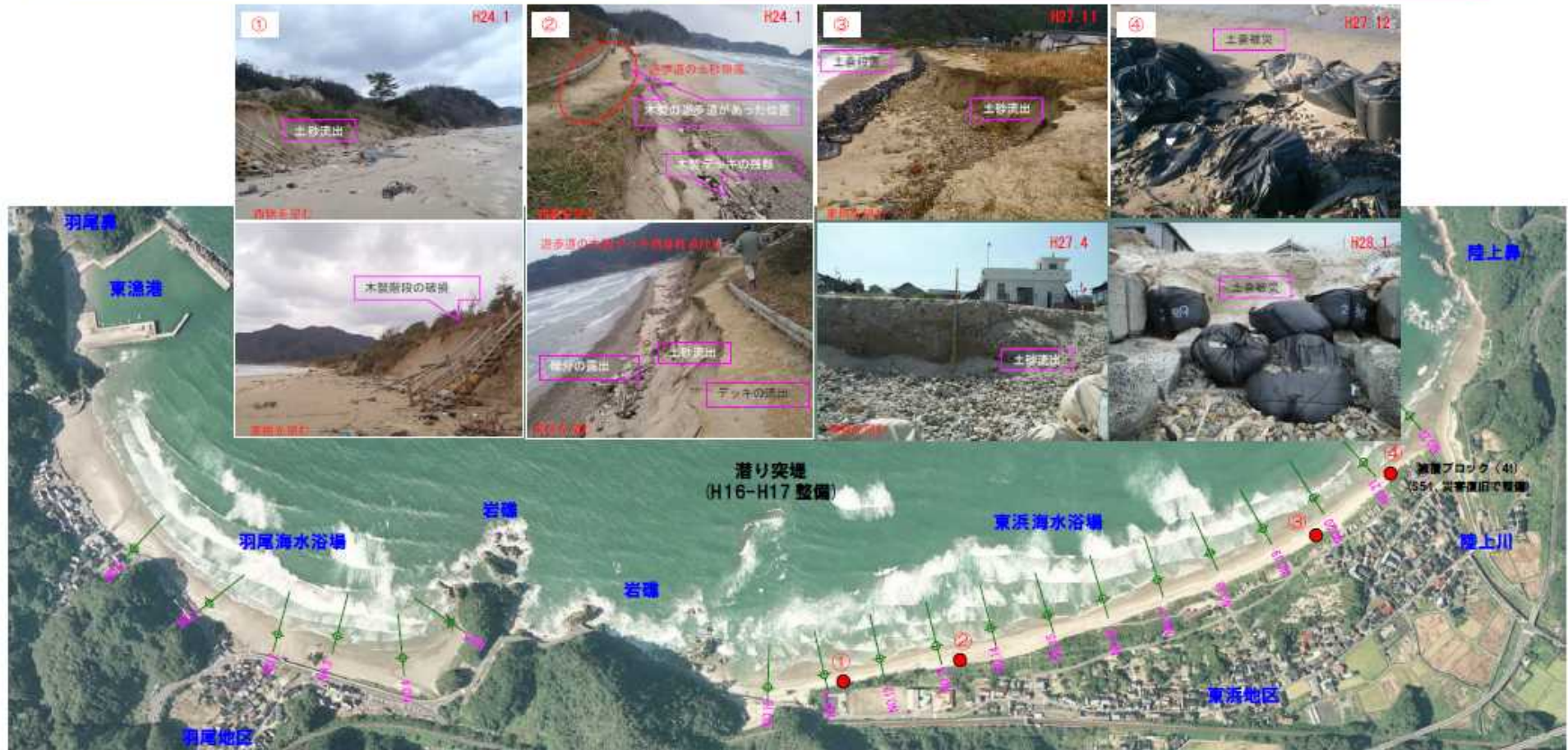
図 1-2 陸上地区における現状（被災・対策実施状況、空中写真：H25撮影）
