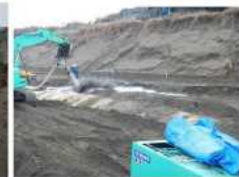
写真 I-4.5.16 埋め戻し部分の水締め
