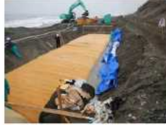
写真 I-4.5.8 浜面保護シート敷設
