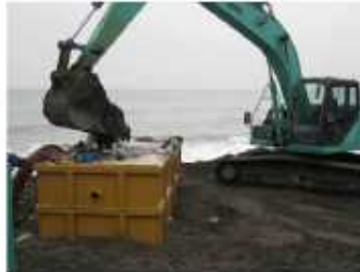
写真 I-4.5.9 中詰め材投入開始
