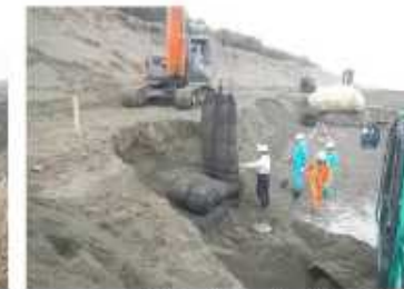
写真1-4.5.2 小口処理設置
