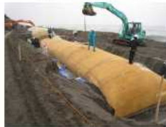
写真 I-4.5.12 充填試完了
