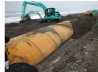
写真 I-4.5.15 背後埋め戻し
