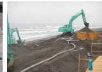
写真1-4.5.6 送水系統と貯砂水槽
