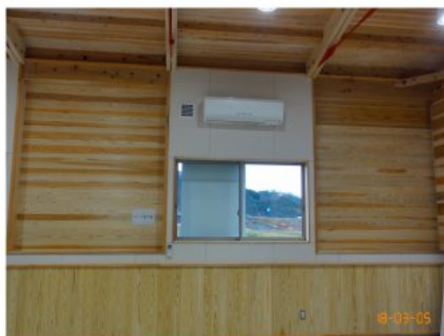
スギCLT耐力壁
