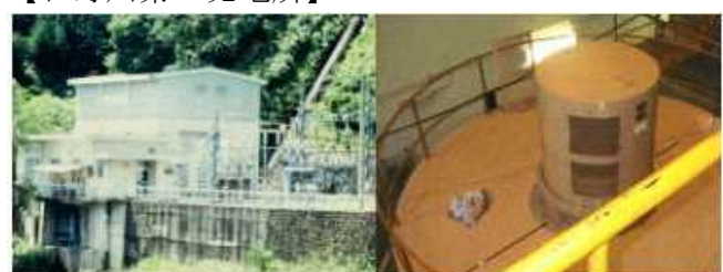
【日野川第一発電所】
