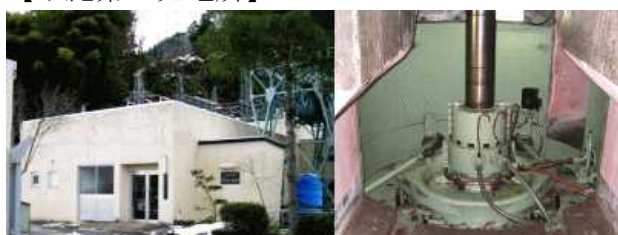
【小鹿第二発電所】
