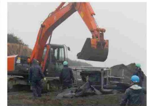
写真 I-4.5.20 大型土嚢製作
