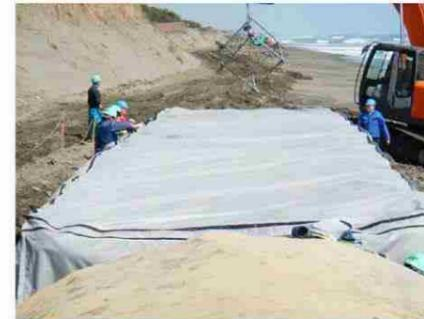
写真 I-4.5.27 土木用ファスナーによる外蓋の設置
