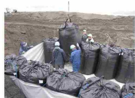
写真 I-4.5.25 中間部分の土嚢割り込み
