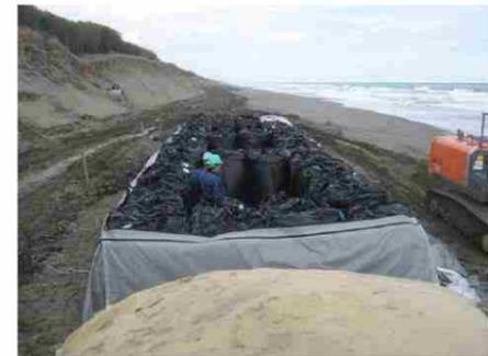
写真 I-4.5.26 外縁部の土嚢が設置された状態
