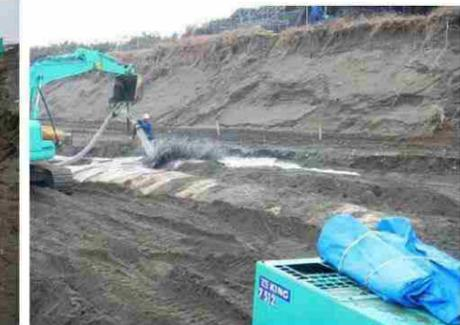
写真 I-4.5.16 埋め戻し部分の水締め
