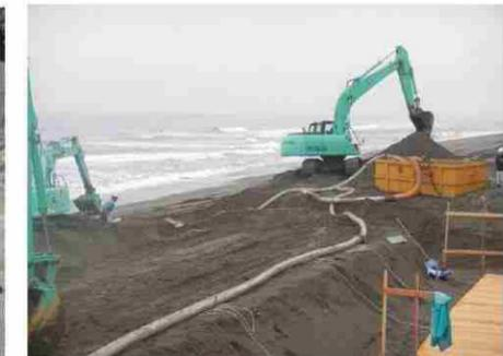
写真 I-4.5.6 送水系統と貯砂水槽
