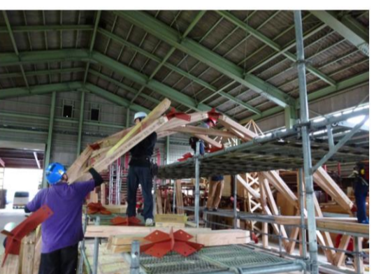
斜材の接合写真
