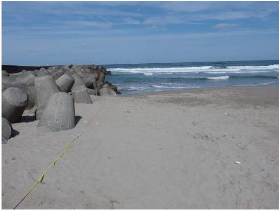
調査現場の規定枠の設置の様子①
