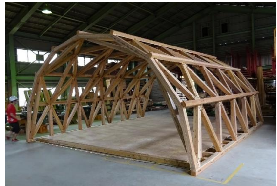
写真8 改良型ヴォールト構造の外観
