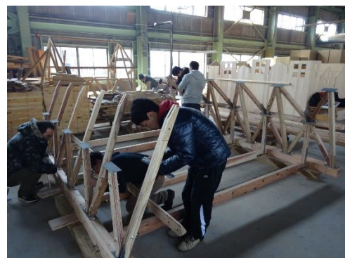
写真3 3mスパンヴォールトの施工状況
