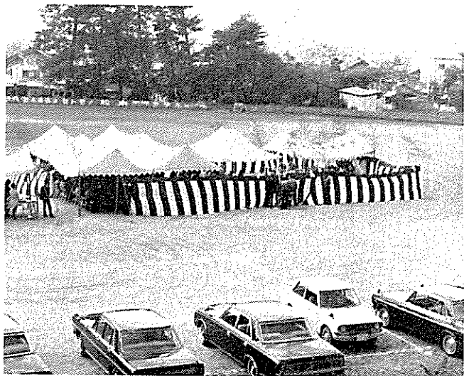
起工式場全景
