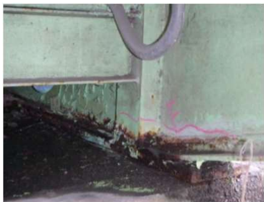
【上部工（主桁）：腐食、健全性Ⅲ】
