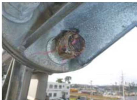
【横梁（標識板取付部）：腐食、健全性Ⅲ】
