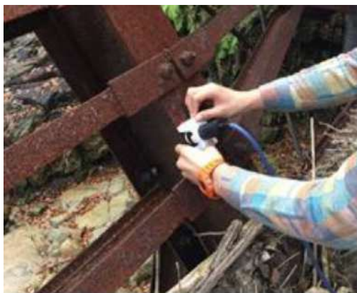
鋼板腐食検査器を使用した調査
