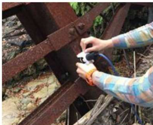
鋼板腐食検査器を使用した調査
