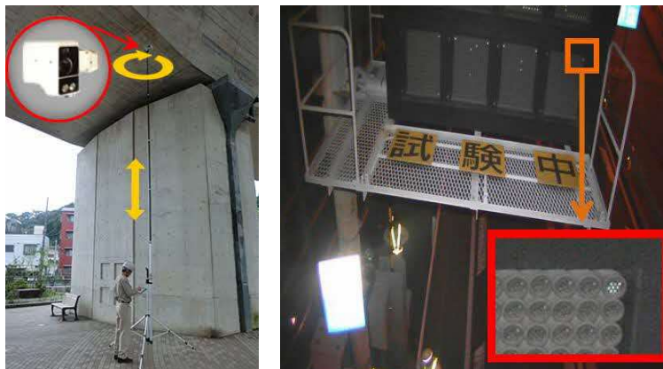
ロボットカメラを使用した点検
