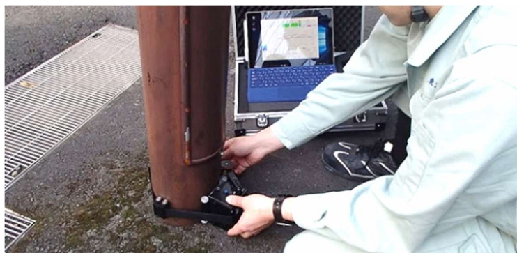
埋設部腐食検査装置を使用した調査
