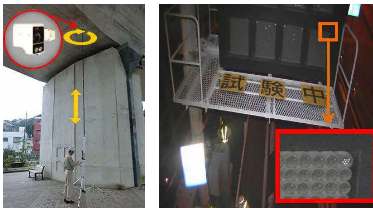
ロボットカメラを使用した点検
