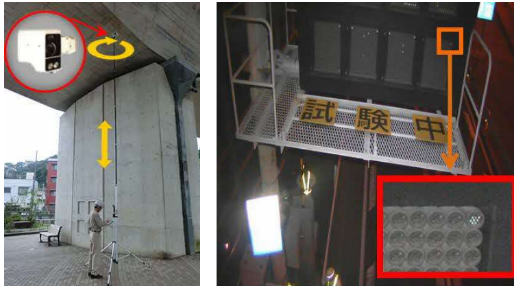
ロボットカメラを使用した点検
