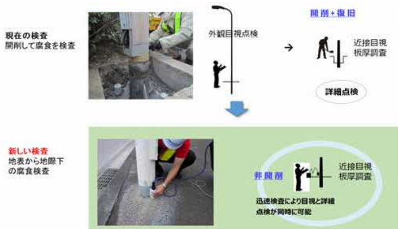
鋼板腐食検査器を使用した調査
