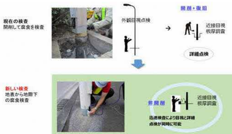
鋼板腐食検査器を使用した調査
