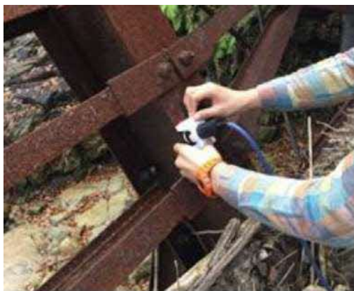
鋼板腐食検査器を使用した調査
