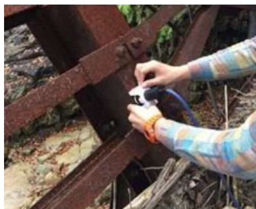
鋼板腐食検査器を使用した調査
