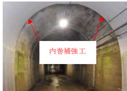
写真2.2 内巻補強工の事例
