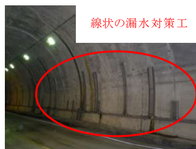
写真2.4 線状の漏水対策工の事例
