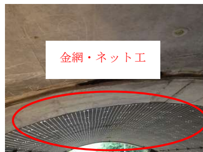
写真2.3 金網・ネット工の事例
