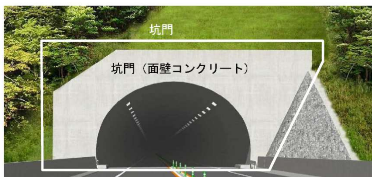
図4.1 トンネル本体工点検箇所
