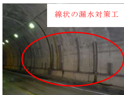
写真2.4 線状の漏水対策工の事例
