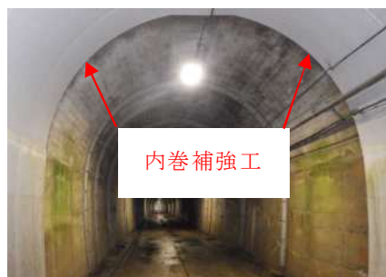
写真2.2 内巻補強工の事例
