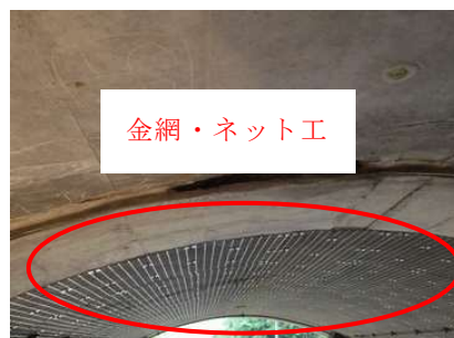
写真2.3 金網・ネット工の事例
