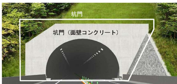
図4.1 トンネル本体工点検箇所
