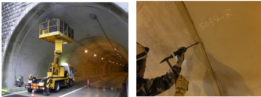
写真4.1 定期点検状況
