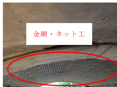
写真2.3 金網・ネット工の事例
