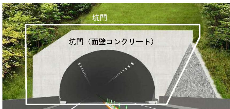
図4.1 トンネル本体工点検箇所
