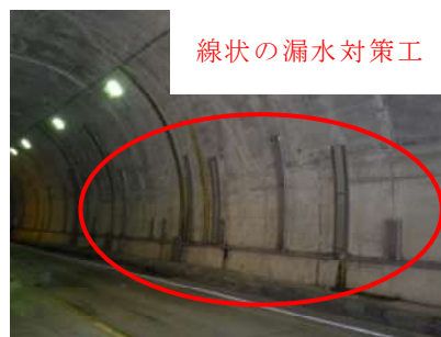
写真2.4 線状の漏水対策工の事例
