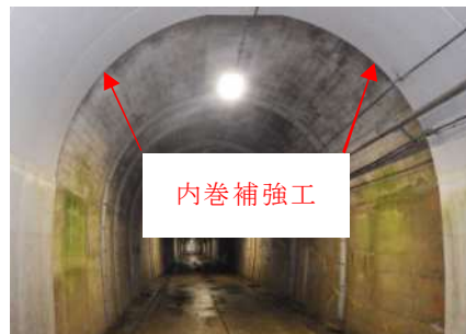
写真2.2 内巻補強工の事例
