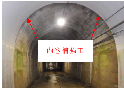
写真2.2 内巻補強工の事例
