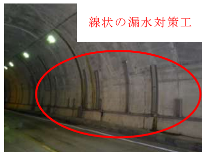
写真2.4 線状の漏水対策工の事例
