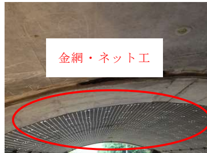
写真2.3 金網・ネット工の事例
