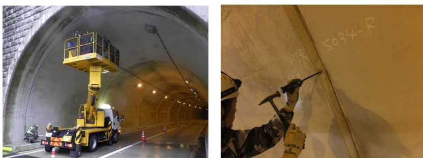
写真4.1 定期点検状況
