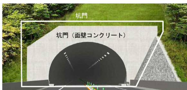
図4.1 トンネル本体工点検箇所
