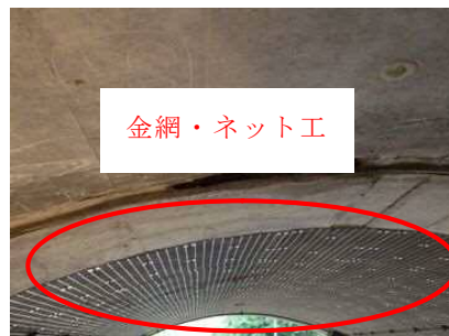
写真2.3 金網・ネット工の事例
