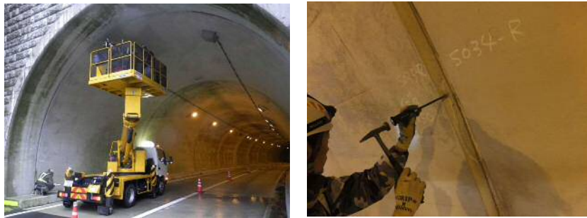
写真4.1 定期点検状況
