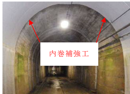
写真2.2 内巻補強工の事例
