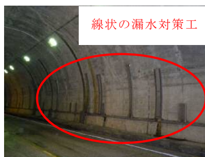
写真2.4 線状の漏水対策工の事例
