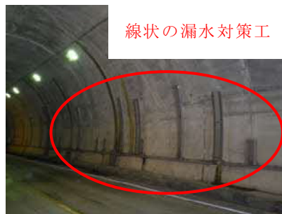
写真2.4 線状の漏水対策工の事例
