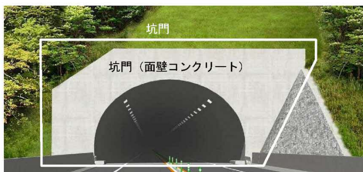
図4.1 トンネル本体工点検箇所
