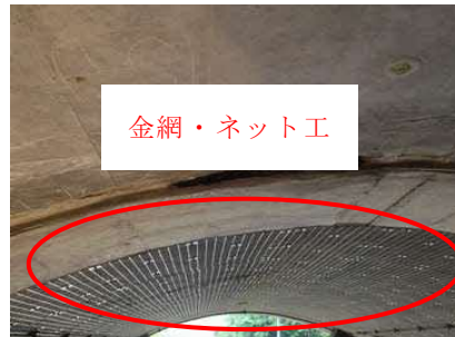
写真2.3 金網・ネット工の事例
