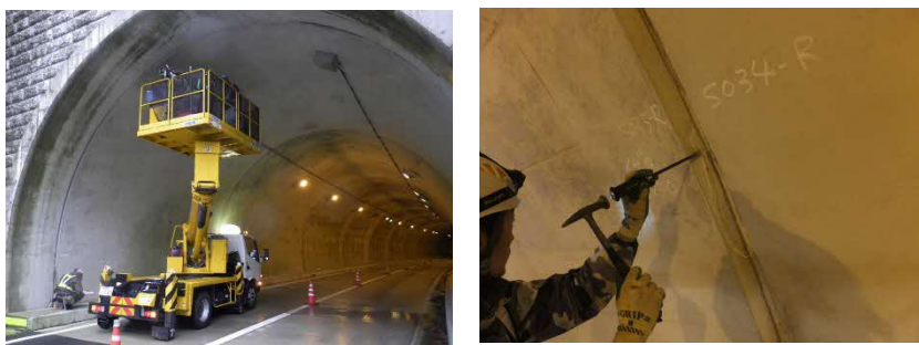
写真4.1 定期点検状況
