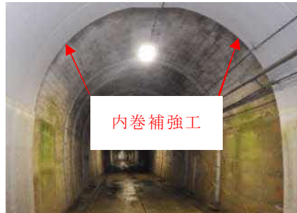
写真2.2 内巻補強工の事例
