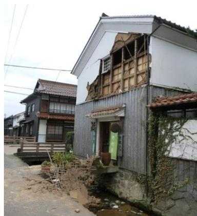
漆喰壁が崩落した倉吉白壁土蔵群
