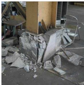
倉吉梨選果場 (支柱破損)
