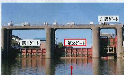
[現在の湖山水門状況写真]
