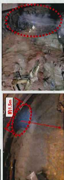
掘削先端部の天井部分から湧水の発生状況(1時間あたり約130トンの出水)の崩落
