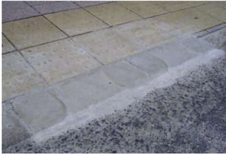
車いす対応縁石への交換
