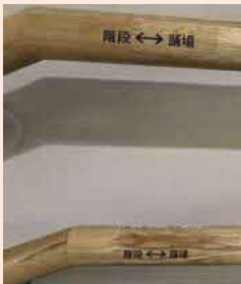
階段手すりの始点・終点がわかりやすいように手すりの先が壁面に埋め込まれている事例となります。また、黒字で階数名称や踊場を示しており、併せて手すりの裏側に点字も併記しています。
