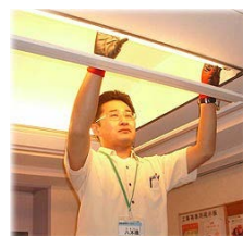
照明器具の交換
