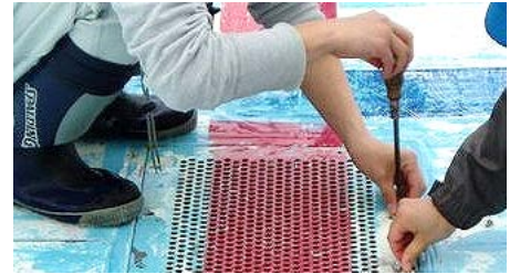
職員による排水溝の点検
