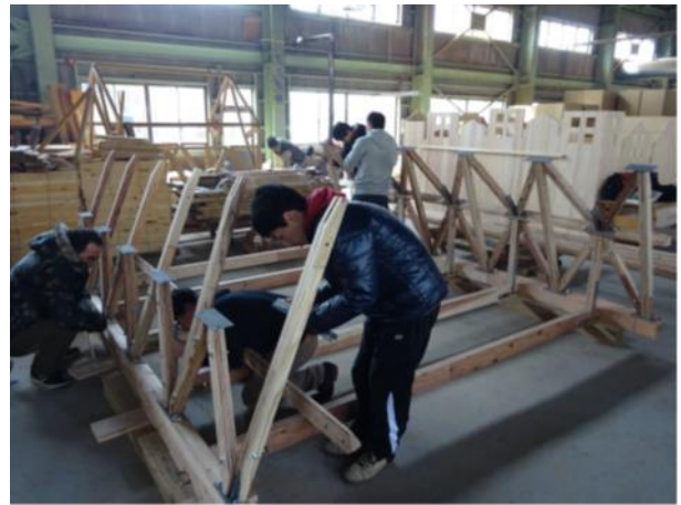
写真1 施工実験の様子
