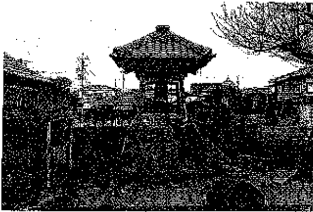
安楽寺鐘楼 外観
