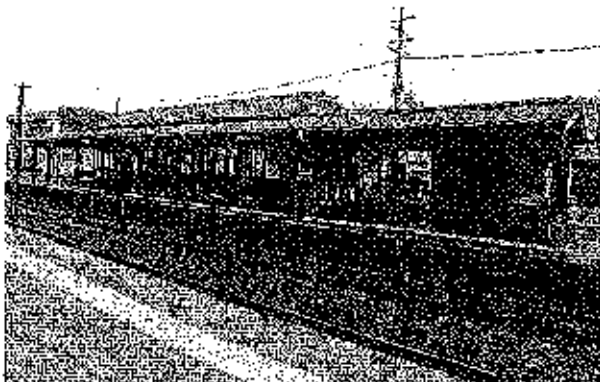
JR山陰本線御来屋駅本屋及び旅客上屋 南面
